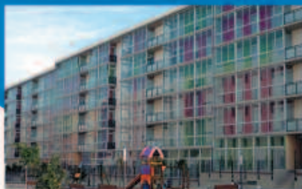
Zaragoza: C/ Isla del Tesoro - C/ Puentes de Madison
